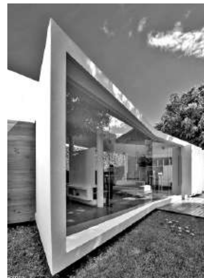
Pabellón S. Fotografía de Luis Gordoa
