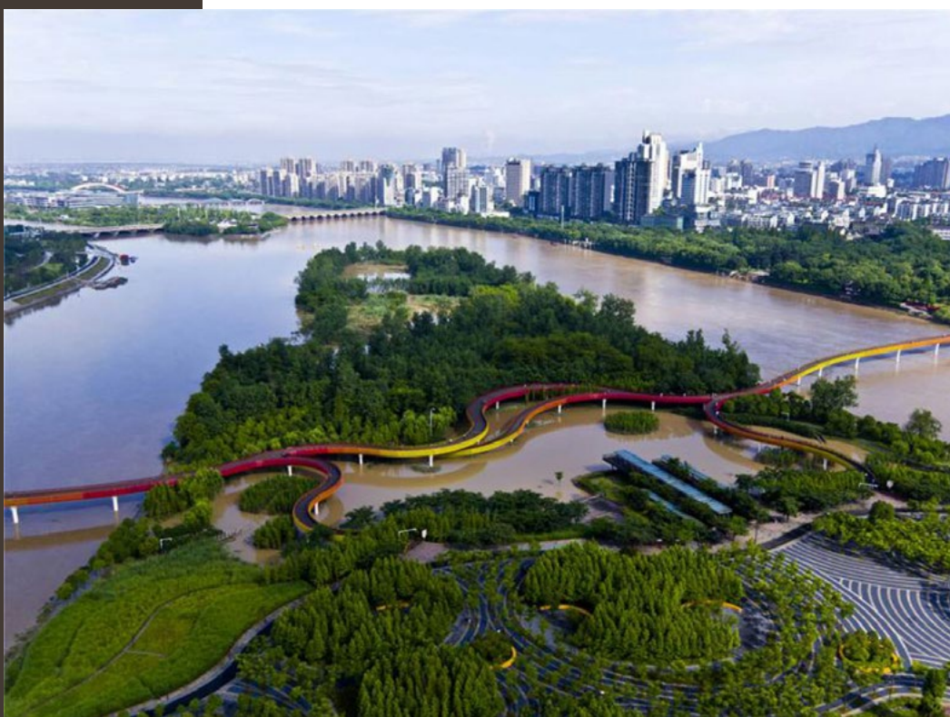
Figura 2. El humedal Yanweizhou, que significa la cola del gorrión, se localiza donde se une el Río Wuyi y el Río Yiwu que al converger forman el Río Jinhua, nombre que también toma esta ciudad. Tomado de https://www.chinese-architects.com/en/turenscape-haidian-district-beijing/project/jinhua-yanweizhou-park
